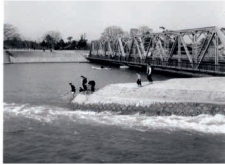
完成直後の西川水路橋に集まる人々
